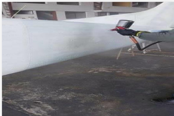
Figura 64 Aplicación de la Pintura Final
