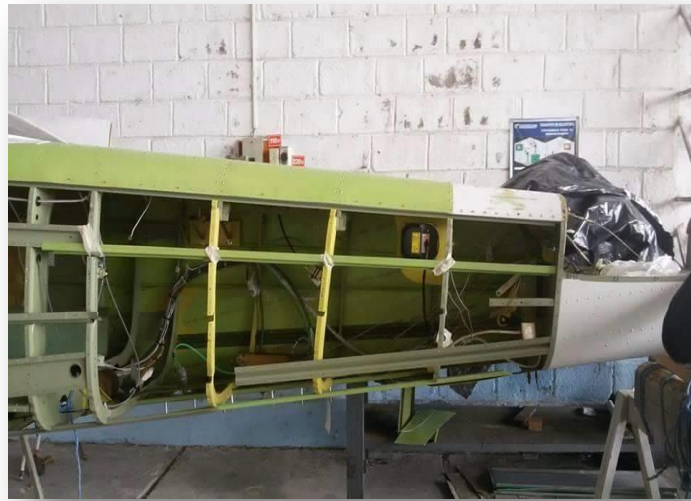
Figura 59 Colocación de largueros.
