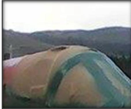
**Figura 46** Cúpula y ventanas protegidas con papel industrial y cinta adhesiva de enmascarar
