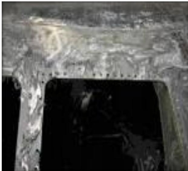
**Figura 9** Corrosión por exfoliación
