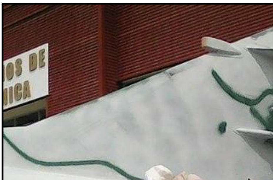
Figura 31 Aplicación finalizada del fondo en el empenaje
