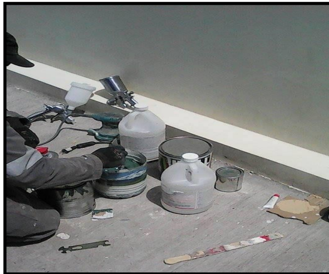
Figura 28 Verificación de la pintura
