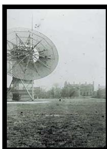
Figura 1.1. La primera turbina eólica construida por Charles F. Brush.
