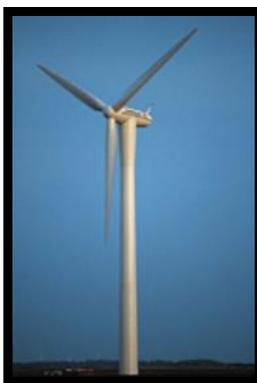
Figura 1.8. Aerogenerador Tripala, con un rotor de 72 m. de diámetro y 80 m. de altura.
