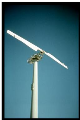
Figura 1.7. Aerogenerador Bipala.
