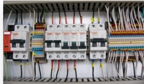
Gráfico 7.38 Cableado Según Código de Colores
