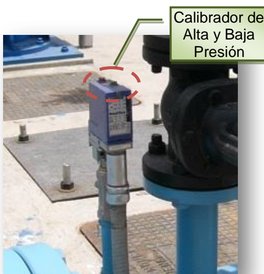
Gráfico 7.47 Conexión de Presóstato
