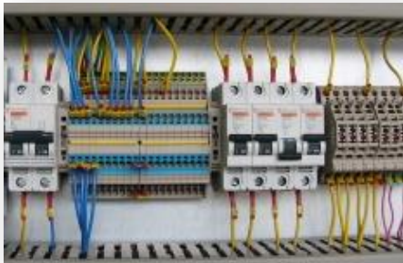
Gráfico 7.38 Cableado Según Código de Colores
