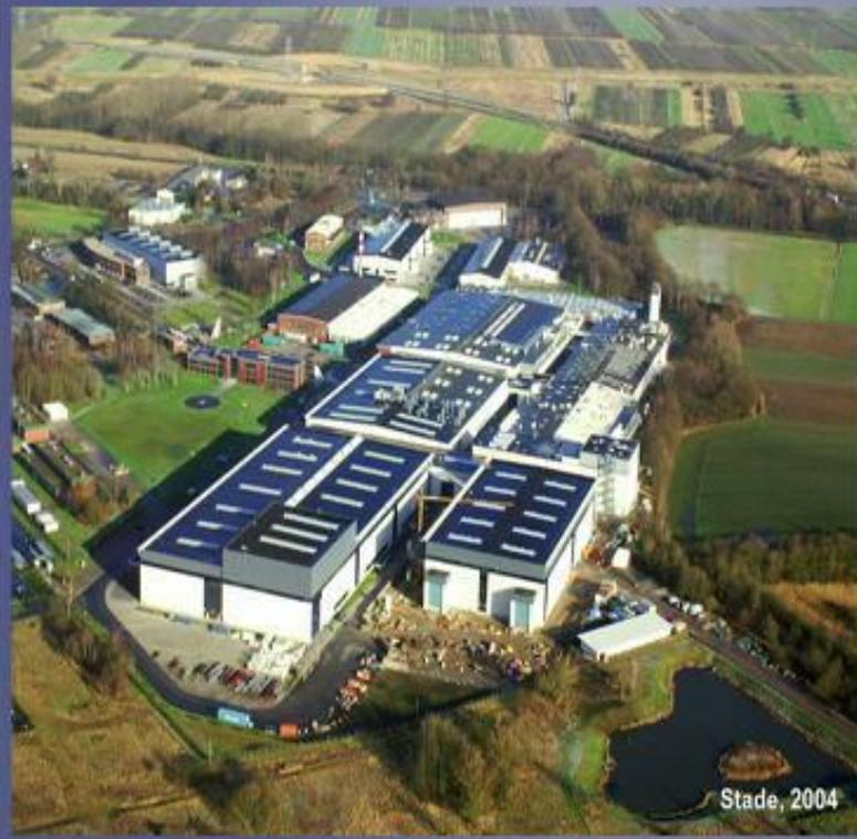
La factoria de Stade se especializa en la producción de estabilizadores verticales, spoilers, flaps y mamparos de presión, construidos con fibra de carbono plástica reforzada (CFRP). Para el 380 producen el empenaje de cola, al mamparo de presión y los flaps. Las instalaciones constan de dos edificios q miden en total 21,000 m<sup>2</sup>
