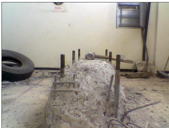
Figura 4.21 Remoción del deposito de aire
