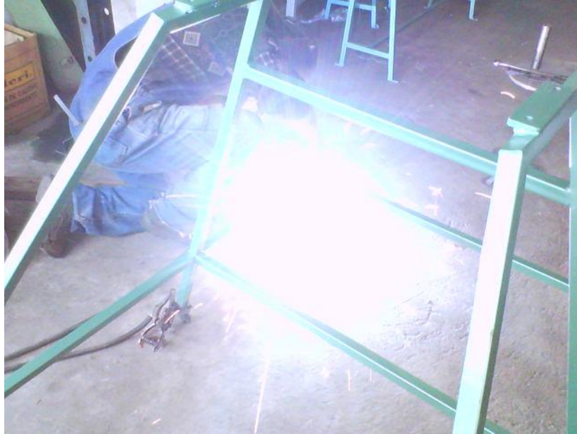
Figura 4.17. Armado de la base del concentrador
