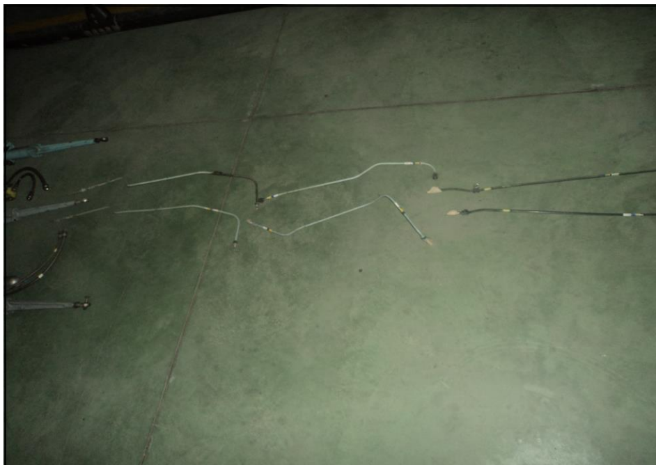
Figura 27 Estado de tuberías Rígidas y Flexibles
