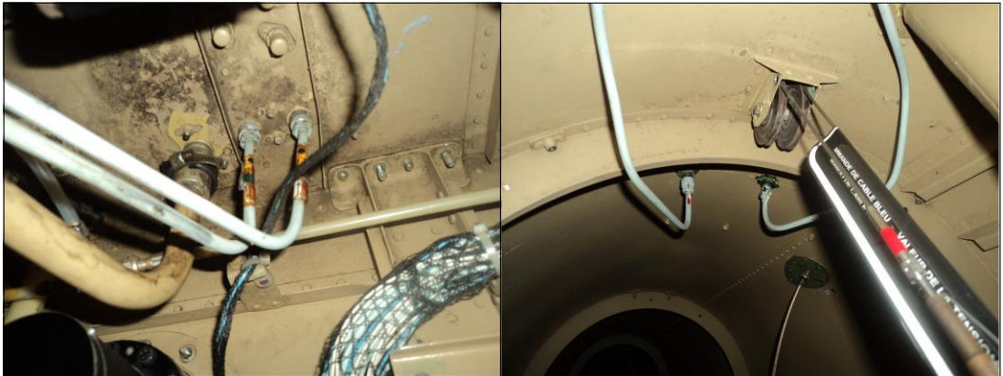
Figura 33 Instalación Tubería Hidráulica 3
