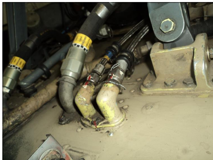
Figura 32 Instalación Tubería Hidráulica 2
