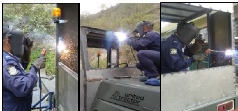
Figura 56. Empate y soldadura del material
