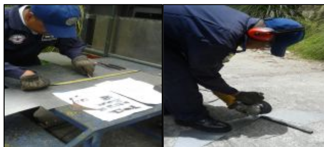
Figura 53. Medición y corte de la plancha de acero
