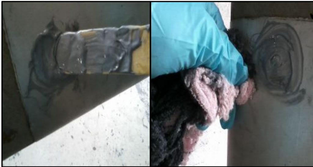
Figura 76. Aplicación de la mezcla en el área a ser reparada.
