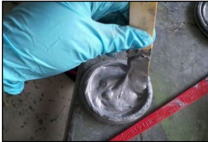
Figura 80. Mezcla de la masilla
