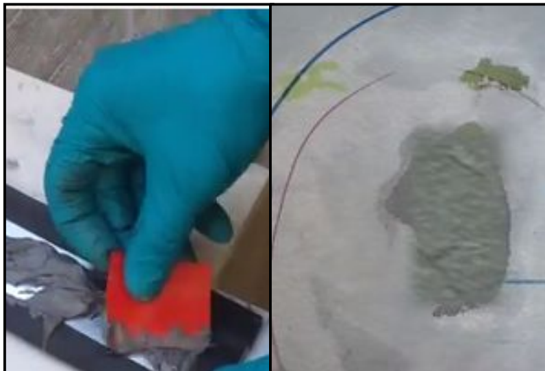
Figura 87. Modo de aplicación de la masilla
