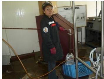
Figura 4.19 Desmontaje de catalizador del Caldero
