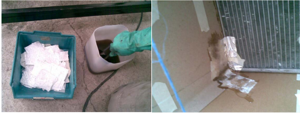
Figura 3. 15 Aplicación de la Resina y la Fibra
