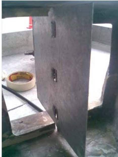
Figura 3. 17 Instalación del eje de la ventolera Fuente: Investigación de Campo
