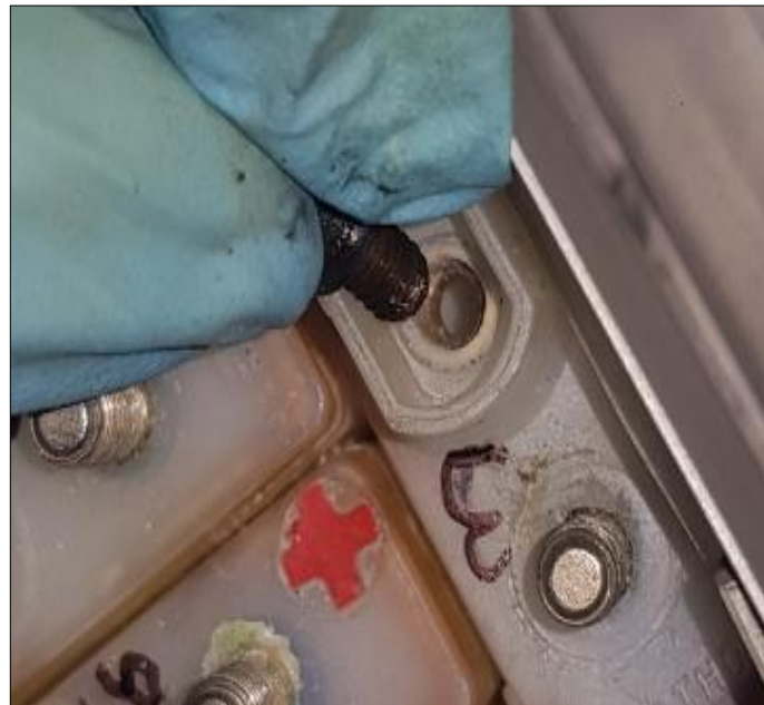
Figura 28 Remoción de las válvulas de ventilación
