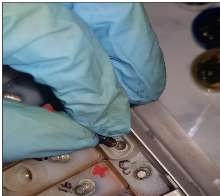
Figura 27 Extracción de las válvulas de ventilación
