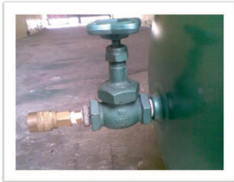
Foto 3.33 Llave de salida del aire con el acople rápido
