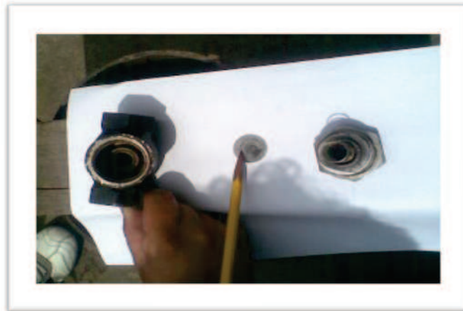
Foto 3.25 Reparación de válvula check
