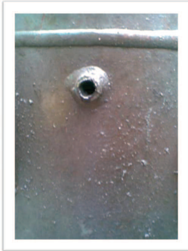
Foto 3.8 Ubicación de la válvula de purga Fuente: Taller de Mecánica Básica Realizado por: Xavier Obando
