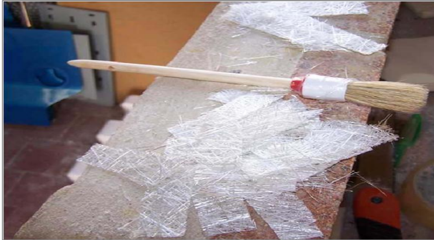
Figura 3.2 Construcción con fibra de vidrio
