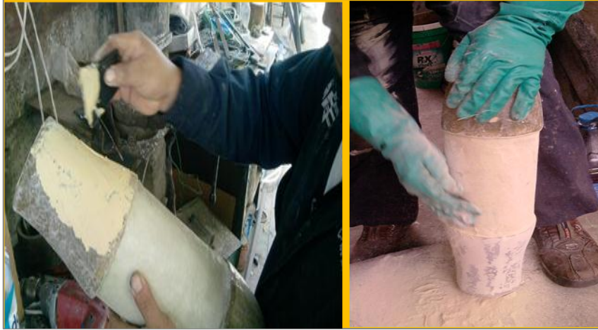
Figura 3.14 Enmasillado y lijado
