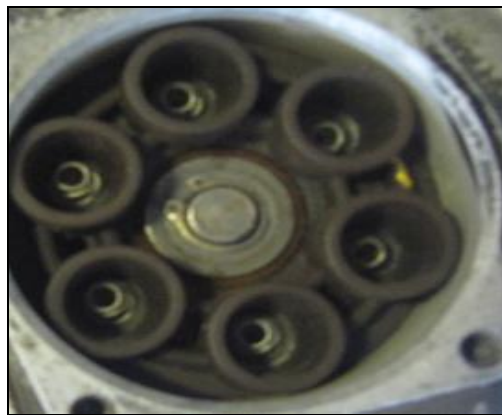
Figura 3.9. Inspección de los contactos tipo resorte
