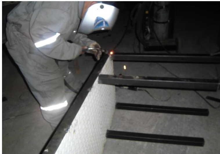
Figura 3.9: Suelda de las bases del tablero. Fuente: Investigación de Campo.
