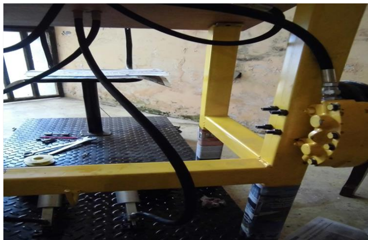
Figura 3.18: Conexión terminada. Fuente: Investigación de Campo.
