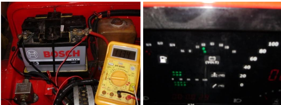
Figura 4.7 Prueba del voltaje de batería
