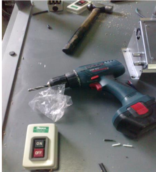
Figura 3.54: Instalación de interruptor Fuente: Investigación de campo
