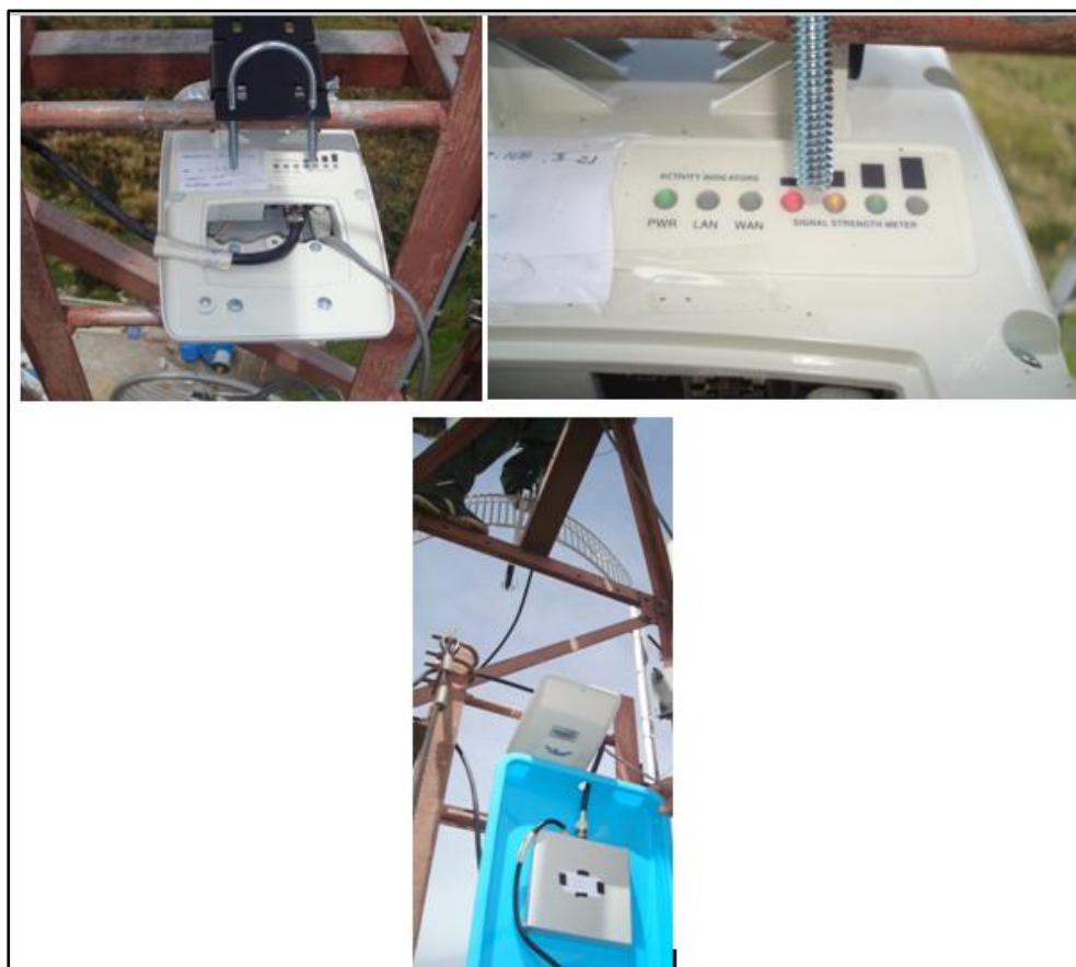
Figura 4. 37 Instalación de Equipo
