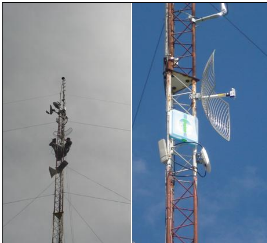
Figura 4. 35 Montaje de Equipos en la torre
