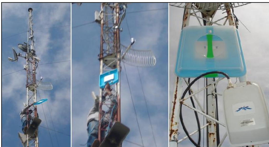
Figura 4. 34 Secuencia de instalación de Equipos
