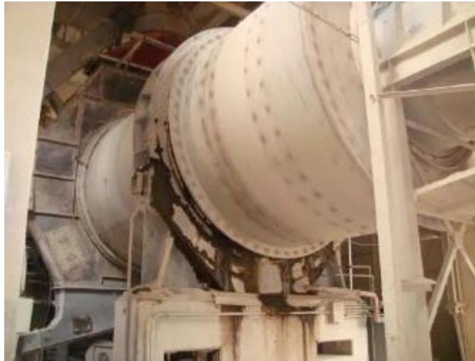
Sistema de molienda de crudo
