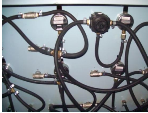
Fig. 5.9. Fijación de mangueras mediante abrazaderas
