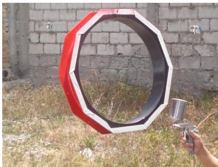
Figura 4. 15 Acabado y pintado de la zona de seguridad
