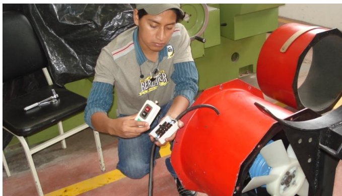
Figura 4. 36 Instalando el interruptor del motor eléctrico
