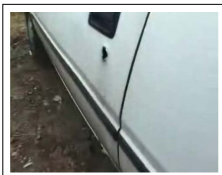
Figura 1.8 - Retiro total de la chapa y abertura de la puerta.
