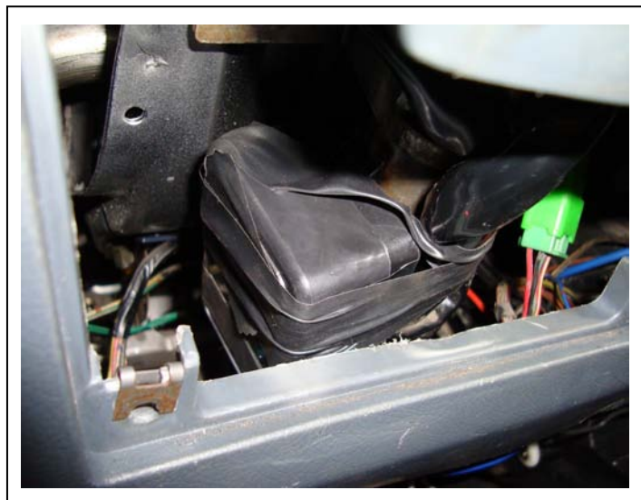
Figura 3.29 - Ubicación del puente H vidrios.
