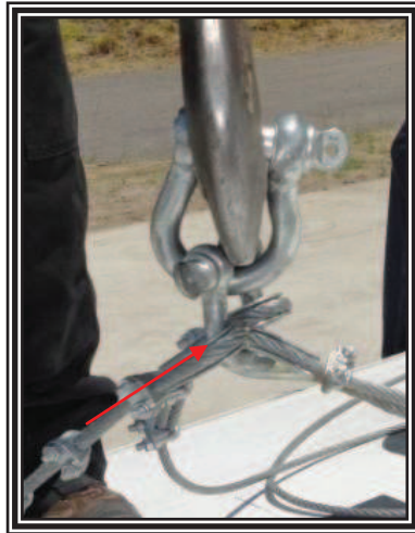
Figura 3.21 Enganche de la eslinga a la punta de la grúa
