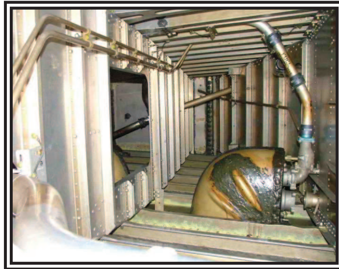
Figura 2.20 Tanque de combustible
