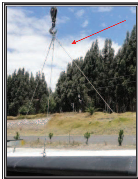
Figura3.22 Levantamiento de la eslinga
