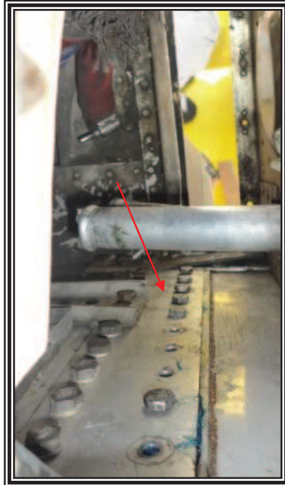
Figura 3.35 Colocación de pernos frontales
