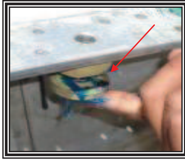
Figura 3.14 Colocación de grasa a los ojaes del ala derecha
