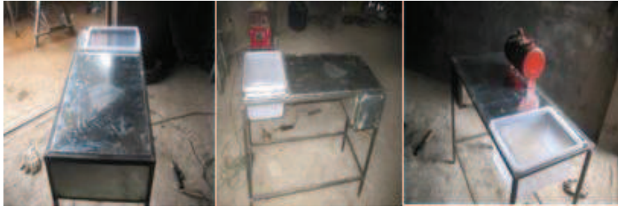
Figura 3.9 Soldadura de la plancha, garruchas y recipiente en la mesa
