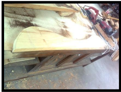
FIG. 26 TABLONES DE CONSTRUCCIÓN
