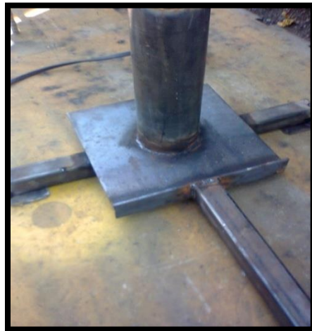
Figura 3.13. Una de las columnas del soporte soldada
