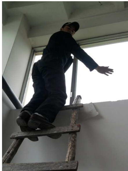
Figura 4.4. Montaje de las ventanas fijas.
