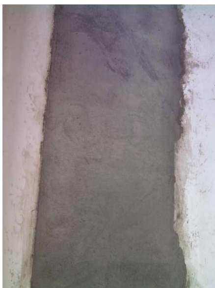
Figura 4.2. Relleno del espacio de la antigua puerta.
