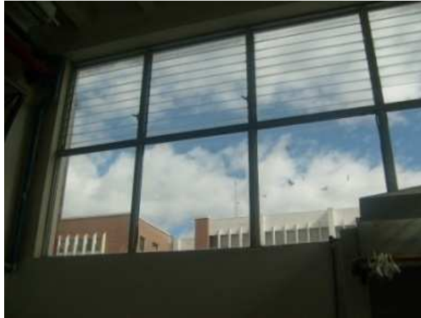
Figura 3.7. Utilización ventanas articuladas.
