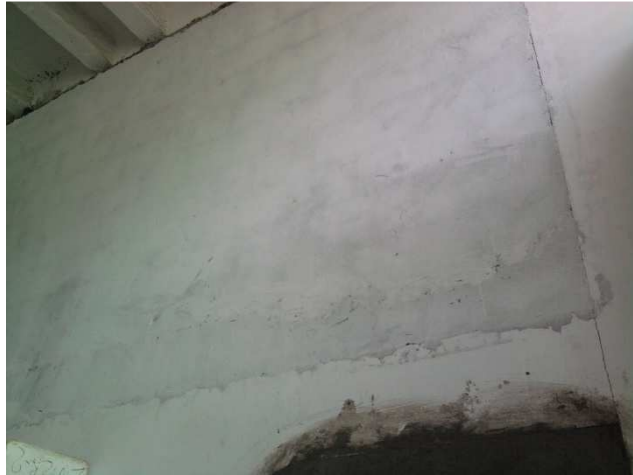
Figura 3.6. Pintado de las paredes del taller deteriorado.
