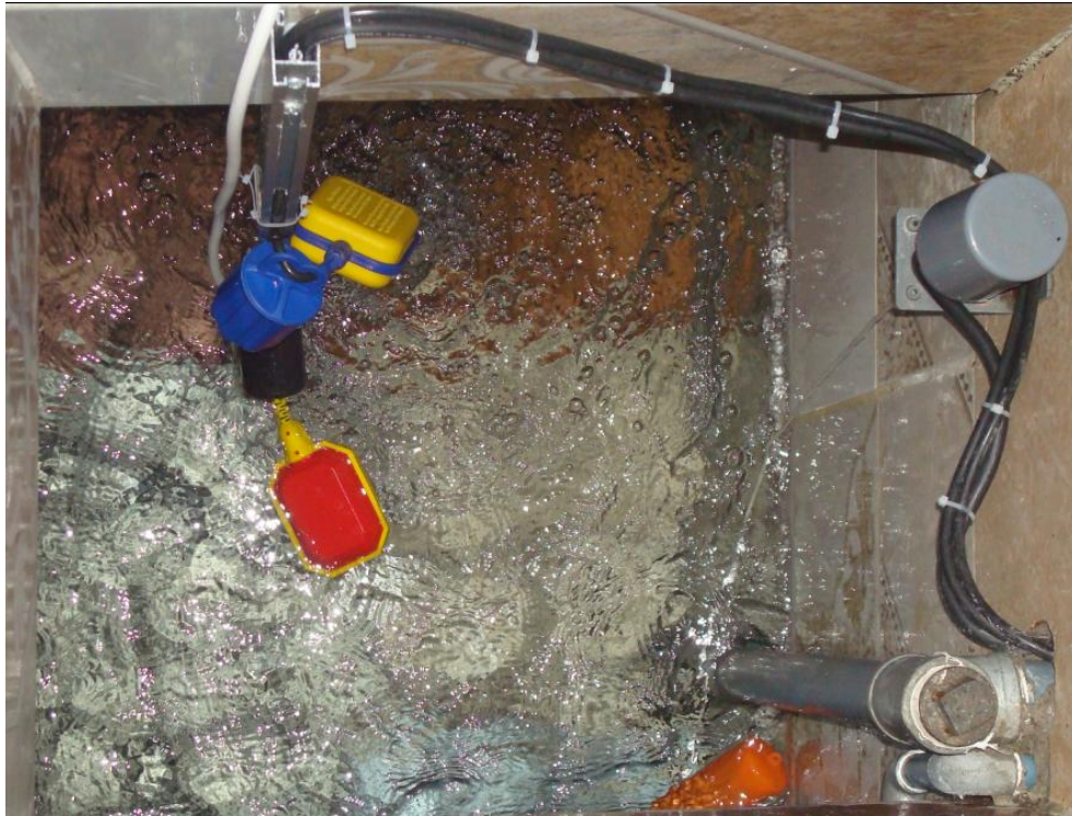
Figura 4. 60 Filtro de Ozono Activo en Cisterna foto 1
