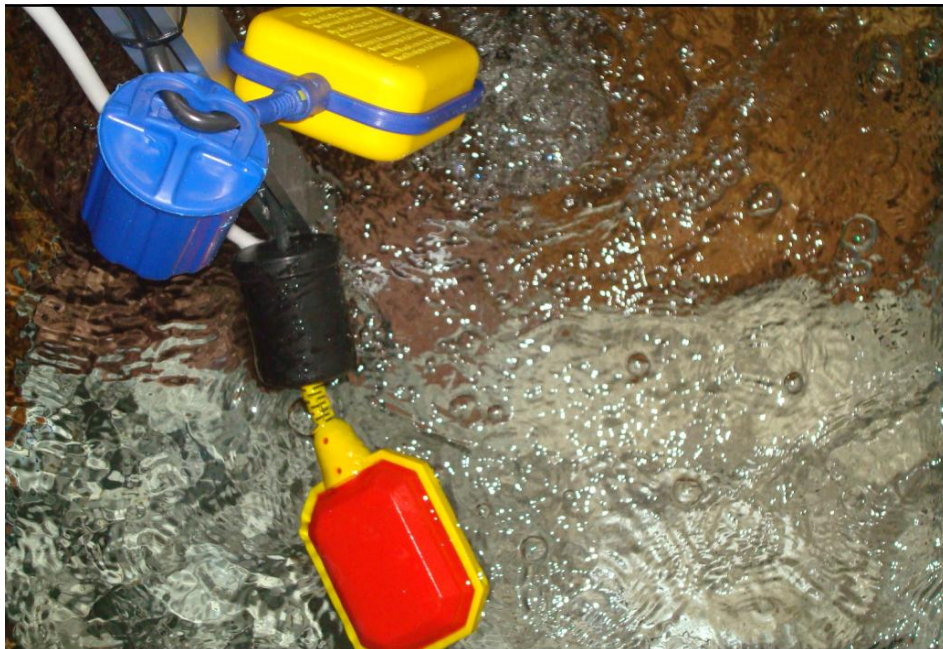
Figura 4. 61 Filtro de Ozono Activo en Cisterna foto 2
