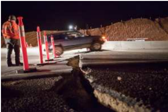
a) Carretera Mexicali -San Felipe
