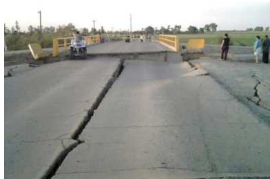
b) Carretera Tijuana-Mexicali, km 80, La Rumorosa
