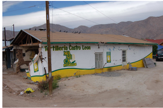
Figura 57 Daños observados en viviendas adobe del valle de Mexicali
