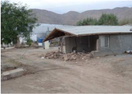
Figura 57 Daños observados en viviendas adobe del valle de Mexicali
