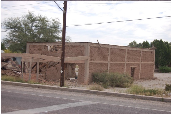
Figura 59 Vivienda de mampostería confinada con base en muros de adobe.
