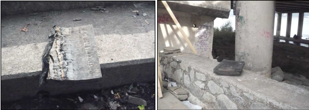
Figura 24 Apoyos de Neopreno de Puente Llacolen.
