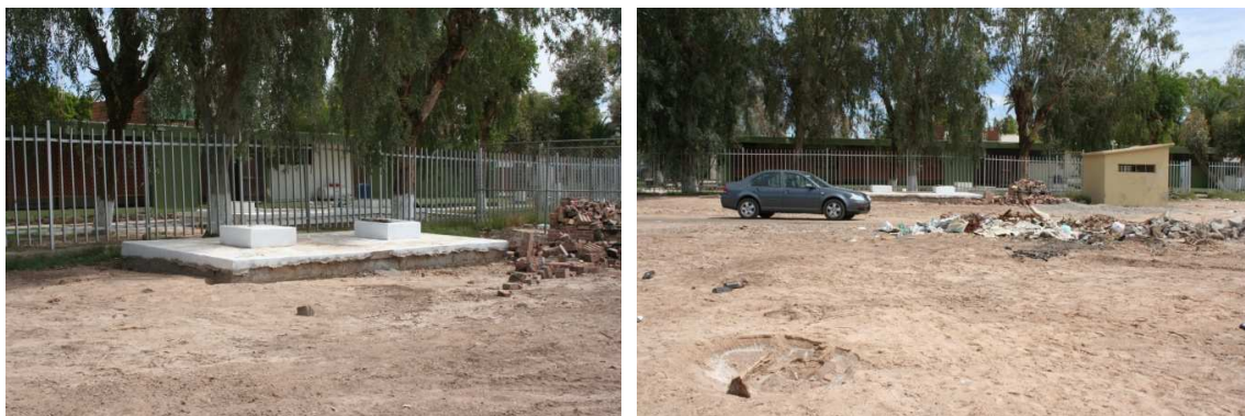
Figura 61 Evidencia de la licuación del suelo de desplante de la clínica rural del IMSS en Ejido Durango.
