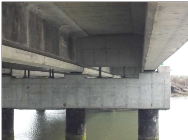
Figura 25 Apoyos de Puente Ballena.
