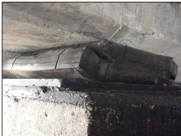
Figura 24 Apoyos de Neopreno de Puente Llacolen.
