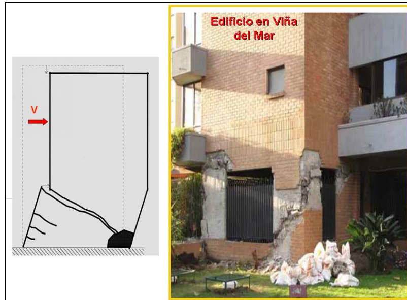
Figura 34 Falla por corte en muros (San Bartolomé et al. 2010).
