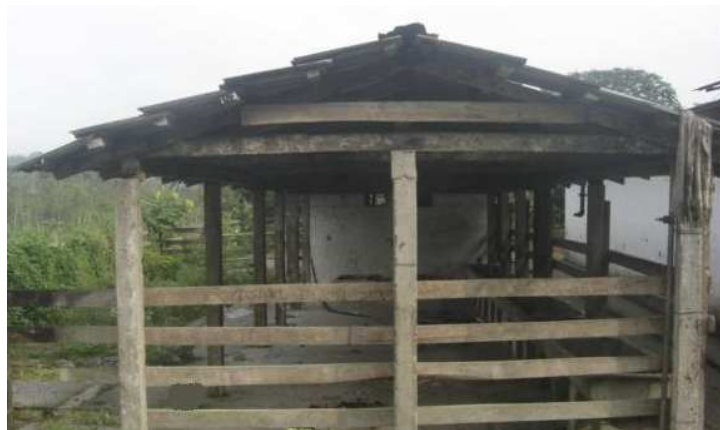
Establo vista lateral.
