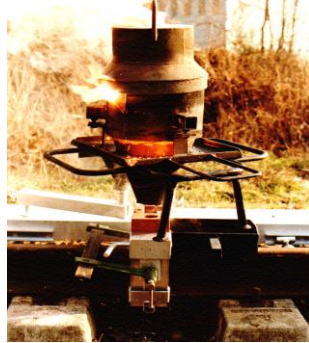
Figura 2.12 Proceso de soldadura aluminotérmica en una línea férrea
