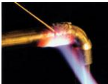
Figura 2.15 Proceso de soldadura fuerte en tuberías
