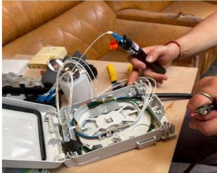
*Nota.* Se observa que con ayuda del localizador de fallas se puede conocer si la fusión realizada fue la correcta, ya que se puede observar el paso de la luz.
