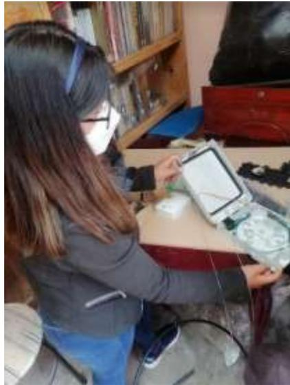
*Nota.* En esta figura se muestra la manera en la que está siendo colocada los cables internos del cable de fibra óptica.
