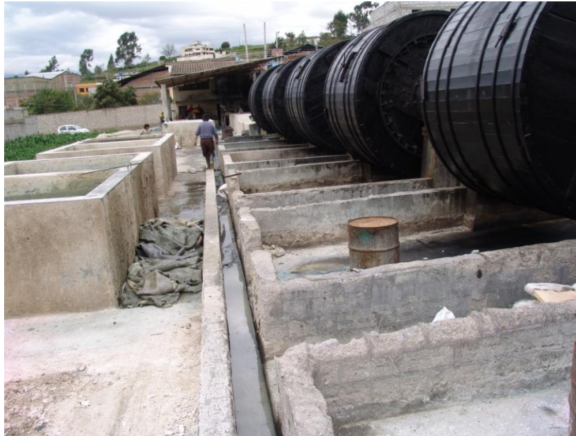
Figura N° 21 Desfogue de agua de curtiembre
