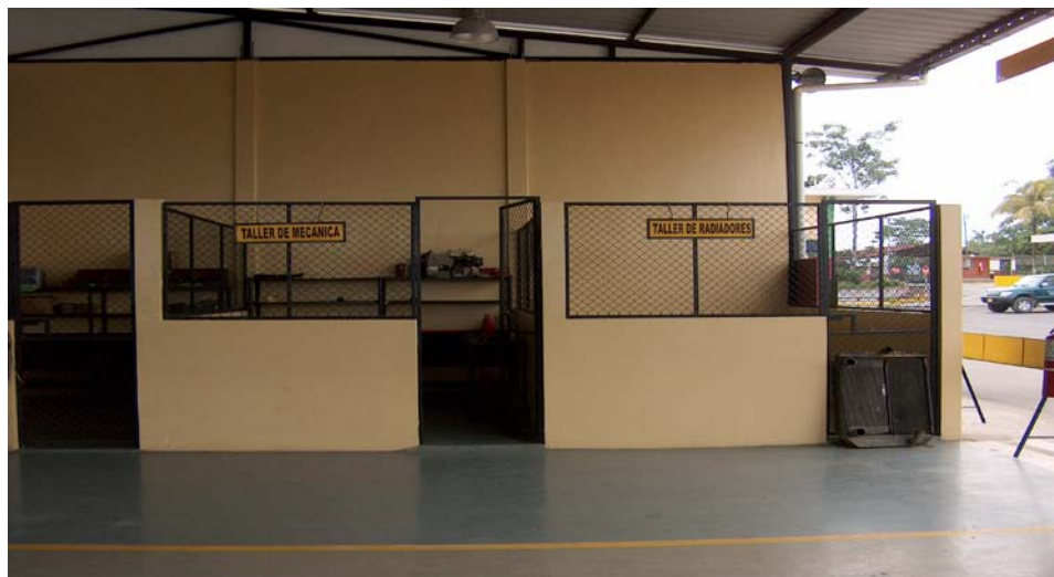
Vista Frontal Talleres de Mecánica y Radiadores
