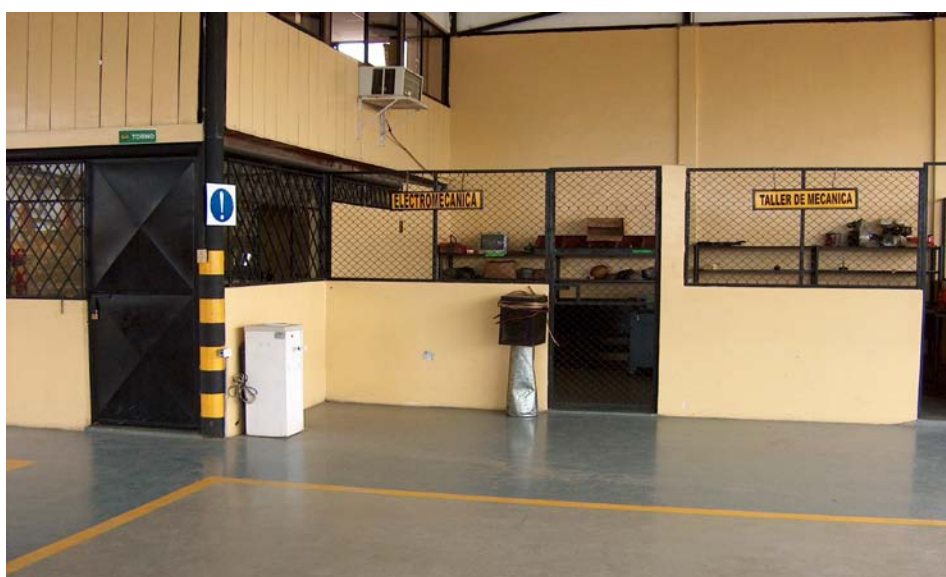
Vista Frontal de Talleres de Electromecánica
