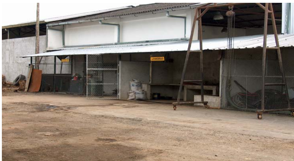
Vista de Bodega de Soldadura y Lavanderia
