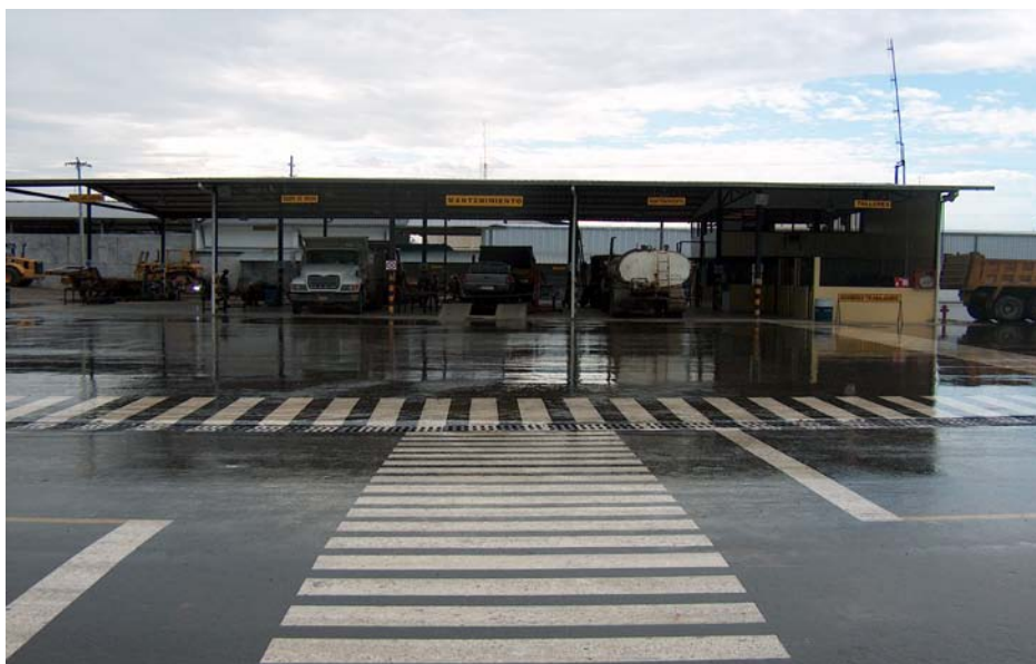
Vista Frontal Taller Mantenimiento GTA
