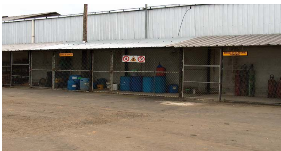
Vista de Bodegas de Soldaduras y Quimicos
