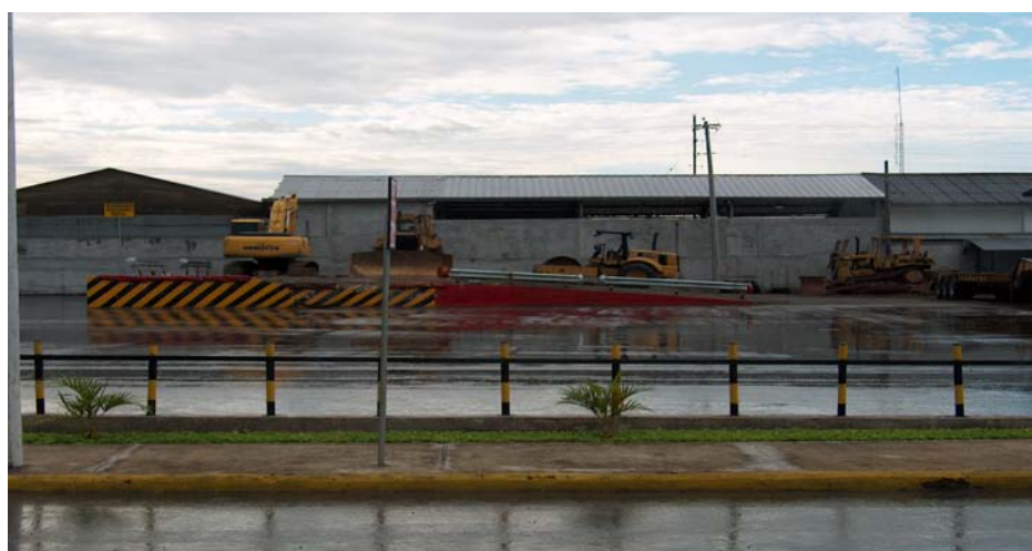
Vista Frontal Plataforma de Carga de Maquinaria
