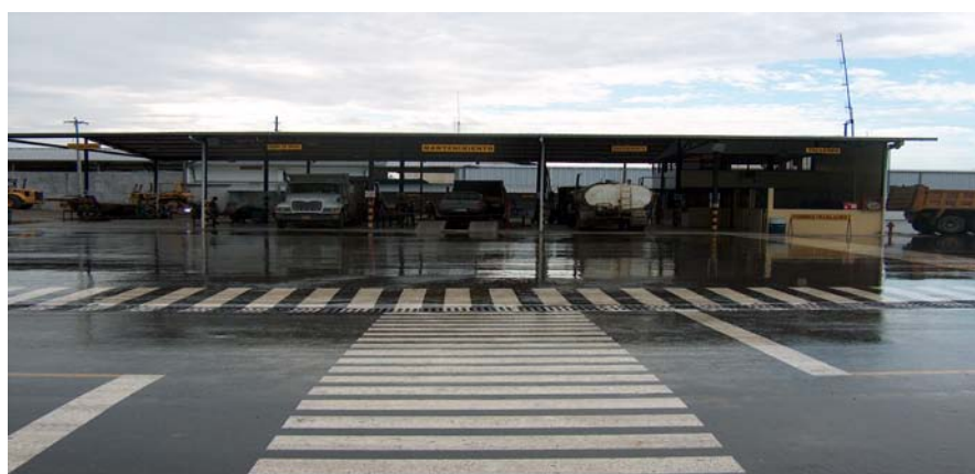
Figura 2.3: Fotografía Vista frontal Área de Mantenimiento GTA
