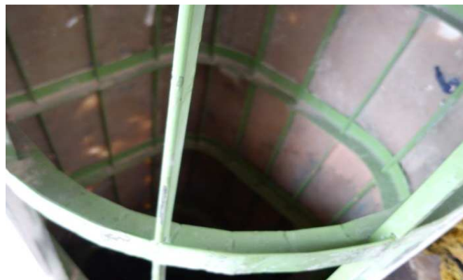
Figura 3.10 Unión de circulares y refuerzos
