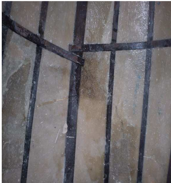
Figura 3.8 Construcción de refuerzos
