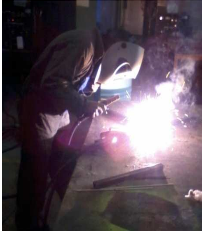
Figura 3.5 Soldadura de circulares
