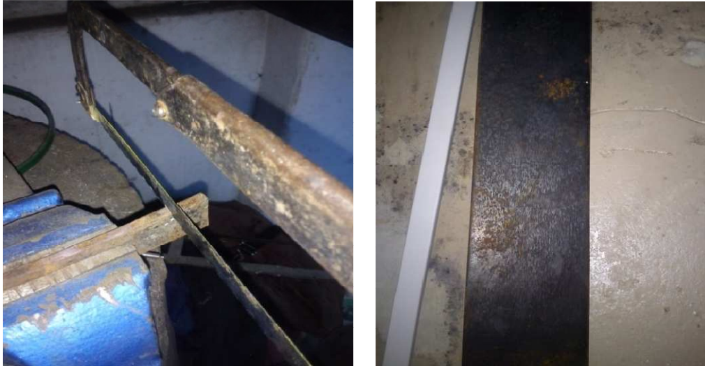
Figura 3.7 Construcción de refuerzos
