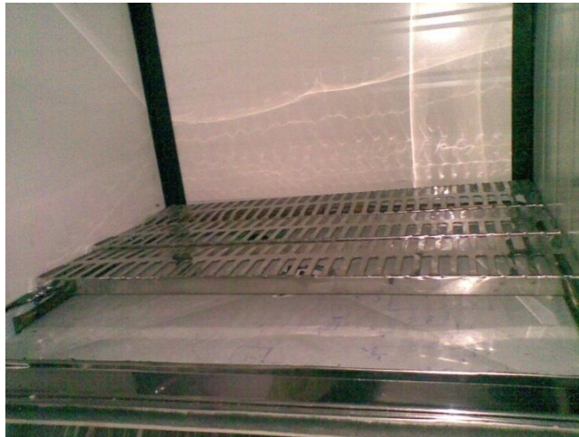
FIGURA 3.8 Instalación de rejillas de soporte del instrumento
