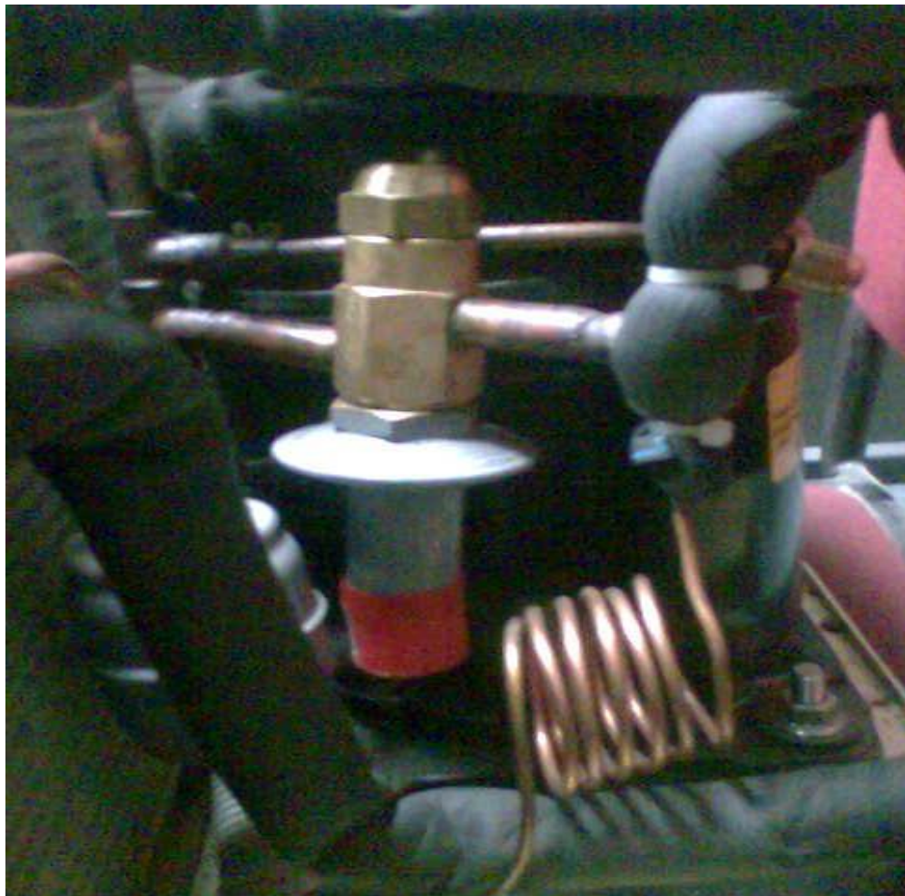
FIGURA 3.12 Instalación tubería de cobre
