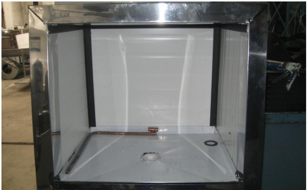
FIGURA 3.7 Instalación tubería de cobre
