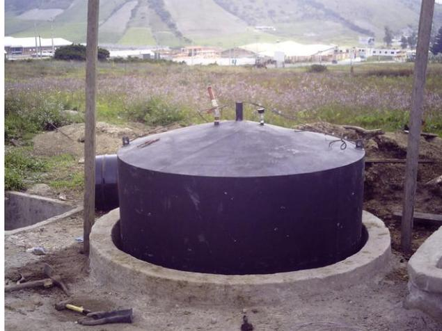
**Fotografía 7.7** Gasómetro a su Nivel Máximo de Elevación con Biogás
