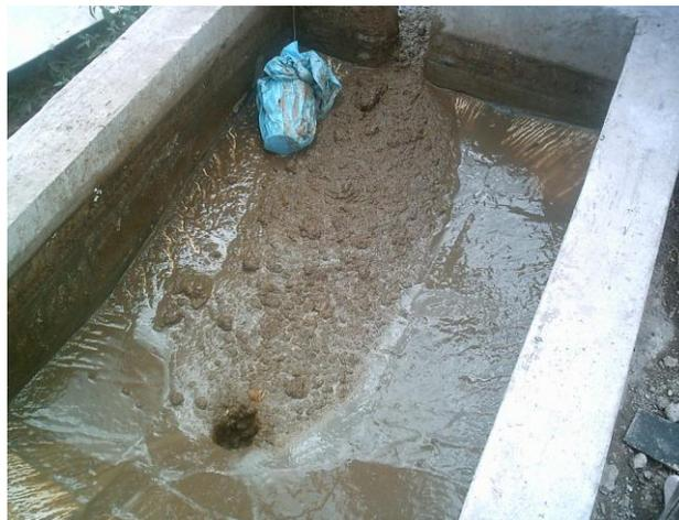
**Fotografía 7.8** Primera Carga al Biodigestor con Estiércol de Ganado Porcino
