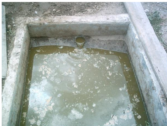
Fotografía 8.10: Recolección del Biol en el Tanque de Descarga.
