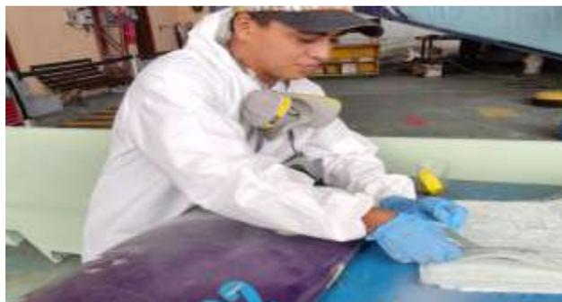
*Nota.* La imagen indica el proceso de recorte de la fibra de vidrio para cubrir las fisuras y fallas que requieren un recubrimiento de fibra de vidrio.
