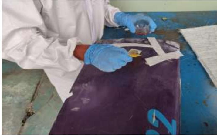
*Nota.* La imagen indica el proceso de aplicación de resina epoxi sobre la fibra de vidrio en las áreas fisuradas.
