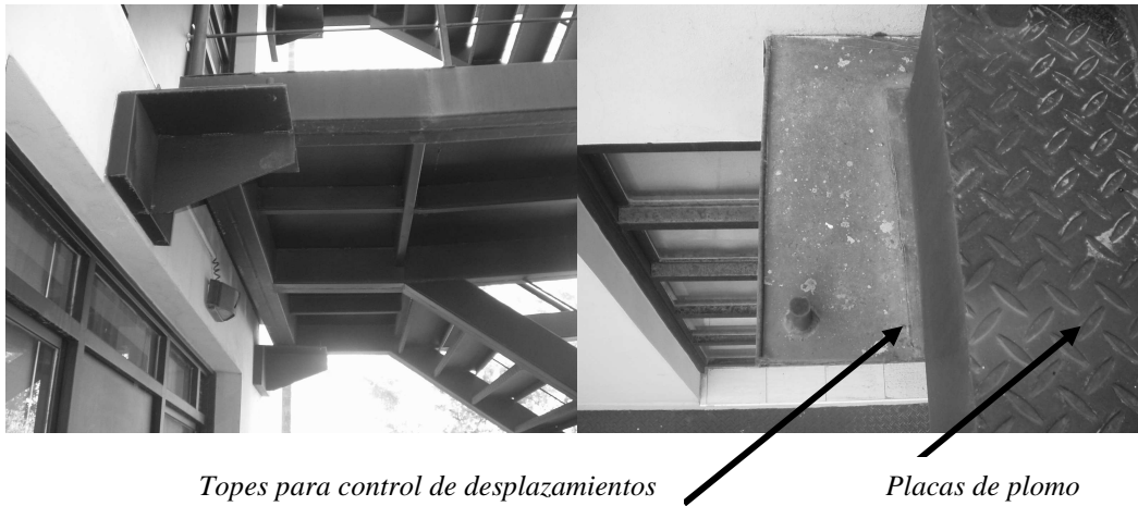
Figura 30 Detalle del encuentro de las escaleras con el edificio aislado
