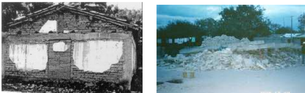
Fig.2. Ometepec, México, 1995. Adobe confinado (izq.) y sin confinar (der.)
