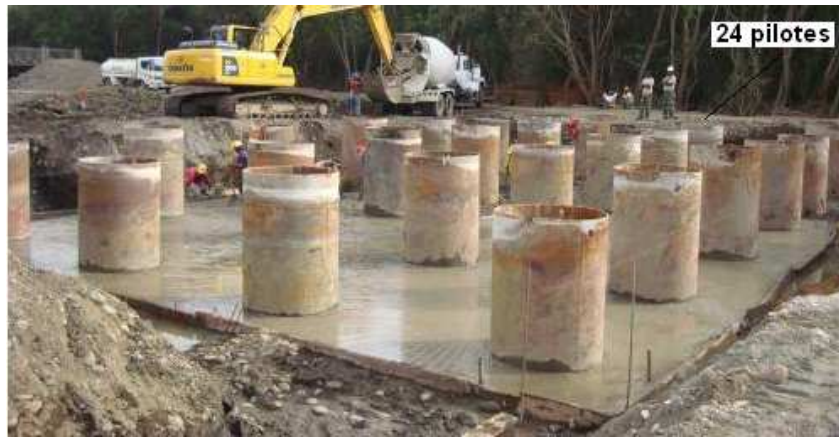
Figura 21 Pilotes de los Estribos del Puente Norte 1.
