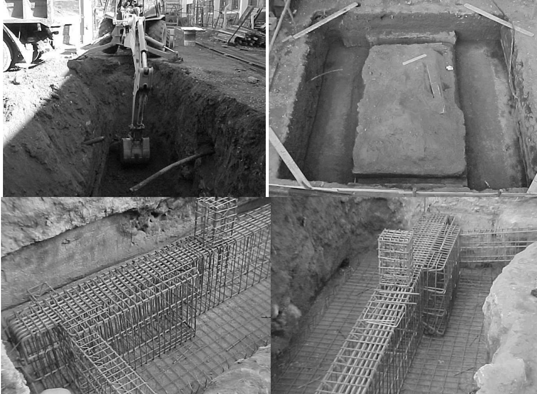
Figura 13 Excavaciones y estructura de fundación por debajo de los dispositivos de aislamiento.
