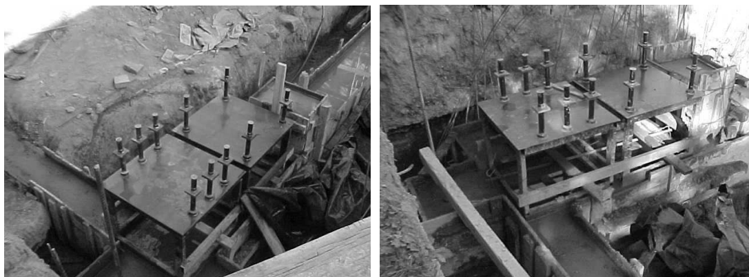
Figura 14 Acciones preventivas para el futuro montaje de los dispositivos de protección.
