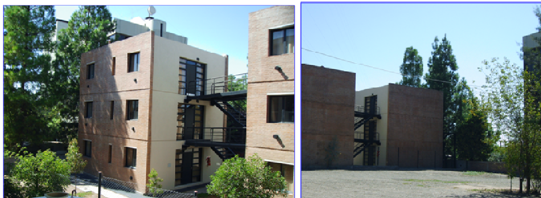
Figura 24 Vista exterior del edificio con aislamiento sísmico
