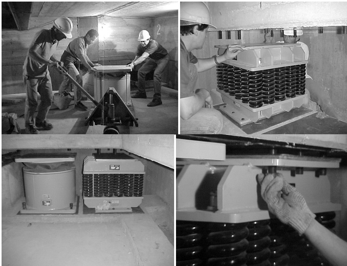
Figura 42 Posicionamiento del sistema de aislamiento en su posición final y del descenso del edificio
