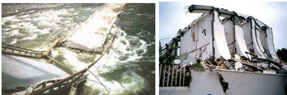
Figura 2 Estructuras colapsadas durante los sismos de 1995 y 1998.
