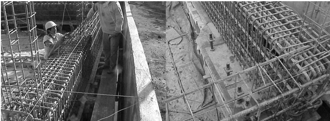
Figura 20 Vigas ubicadas por encima de los dispositivos de aislamiento
