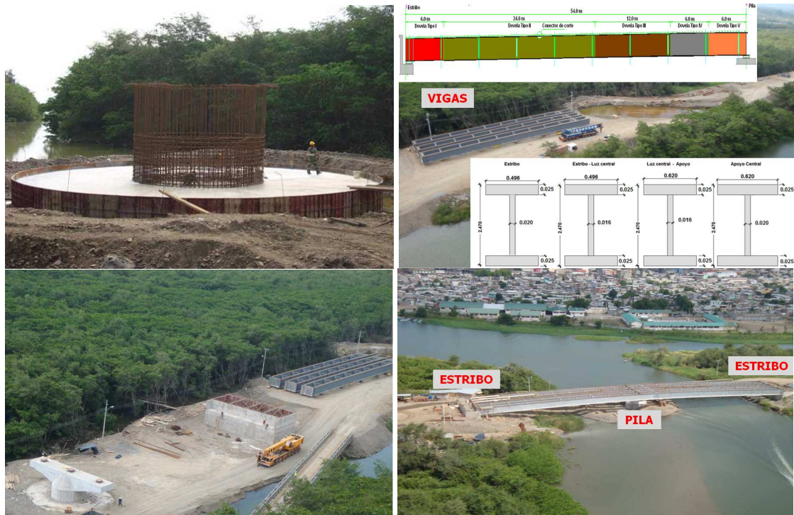
Figura 22 Descripción de la construcción del Puente Norte 1.
