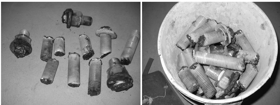
Figura 43 Eliminación de los bulones de pre compresión del aislador para liberar su movimiento.
