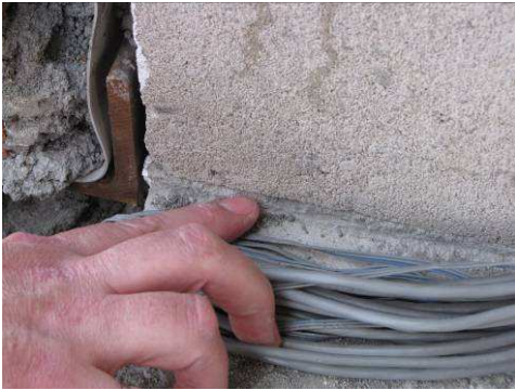
Figura 16 Agrietamiento apenas visible por la puerta del lado sur, antes de 1.50 Tarzana
