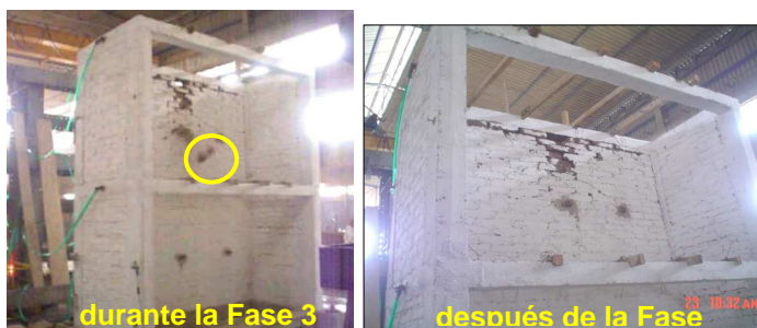
Fig.10. Fase 3. Colapso de un adobe del Piso 2.
