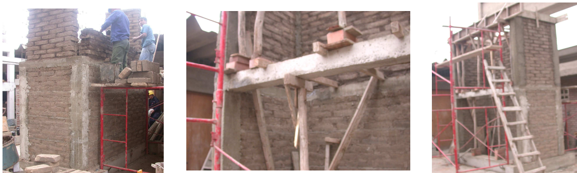
Fig.6. Secuencias de la construcción del segundo piso. En la vista central puede notarse las vigas de madera tallada empleadas en cada nivel.
