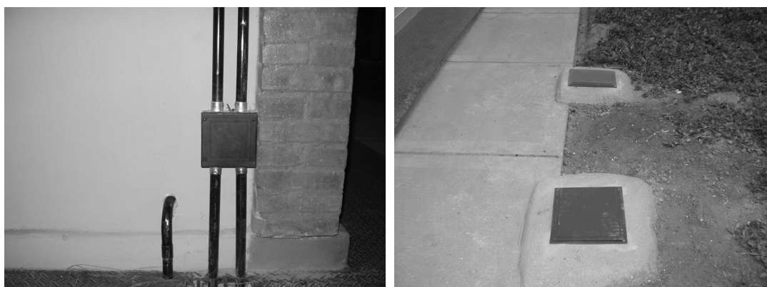
Figura 46 Instalaciones complementarias para el tendido e inspección de los cables de los sensores
