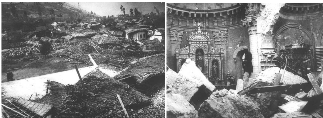
Figura 1 Daño registrados en el sismo de 1949.
