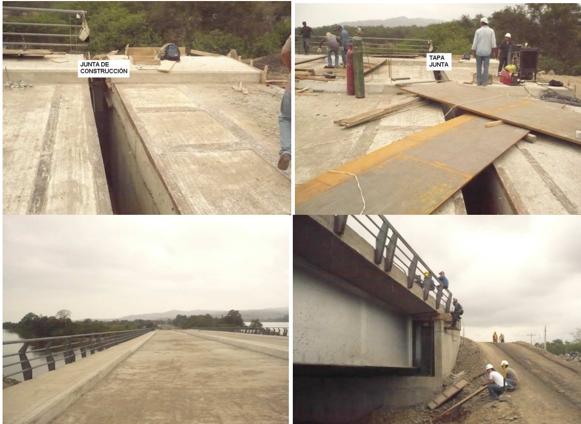
Figura 24 Junta de construcción y vista superior y lateral del Puente Norte
