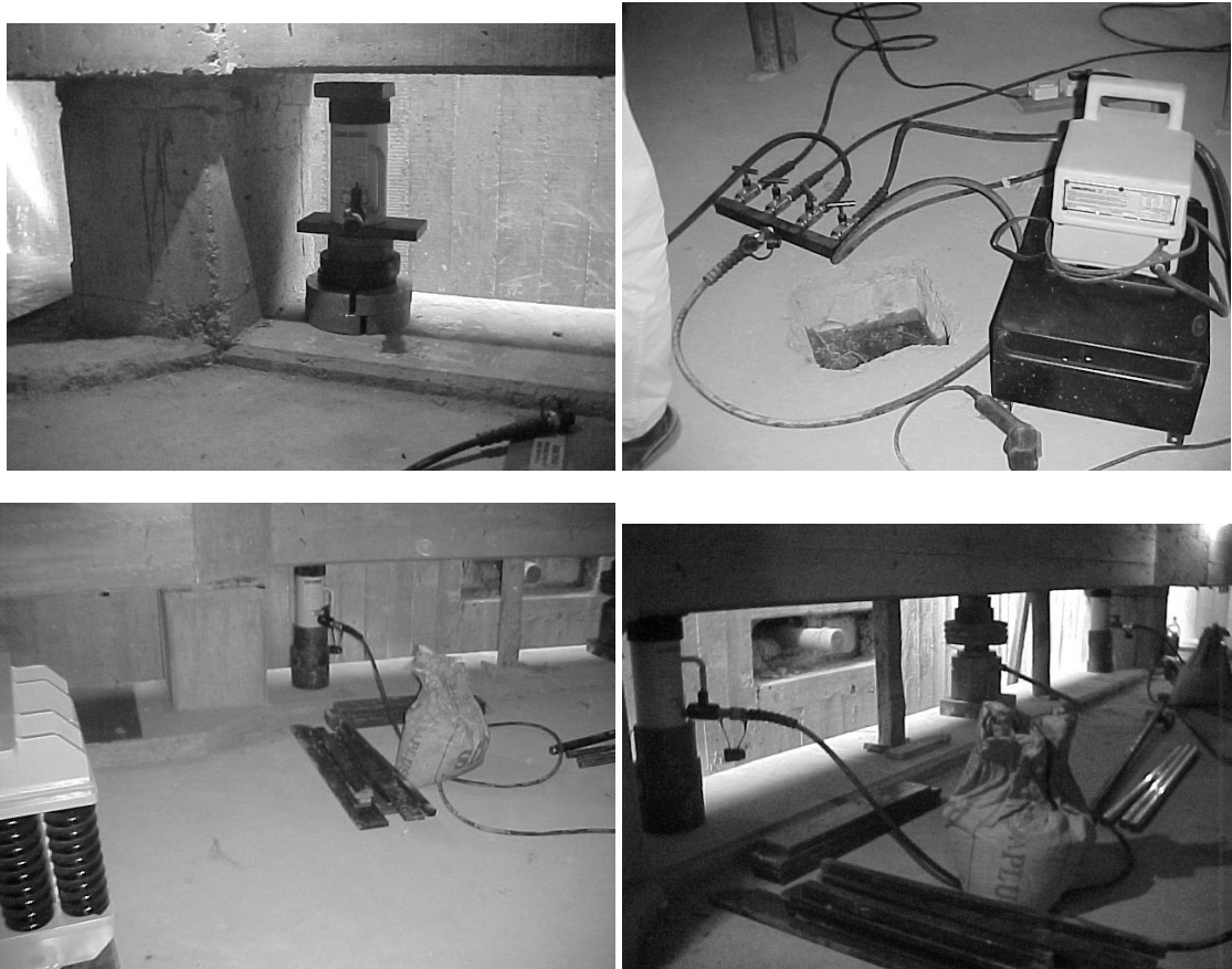
Figura 40 Posicionamiento de los gatos previo al proceso de levantar
