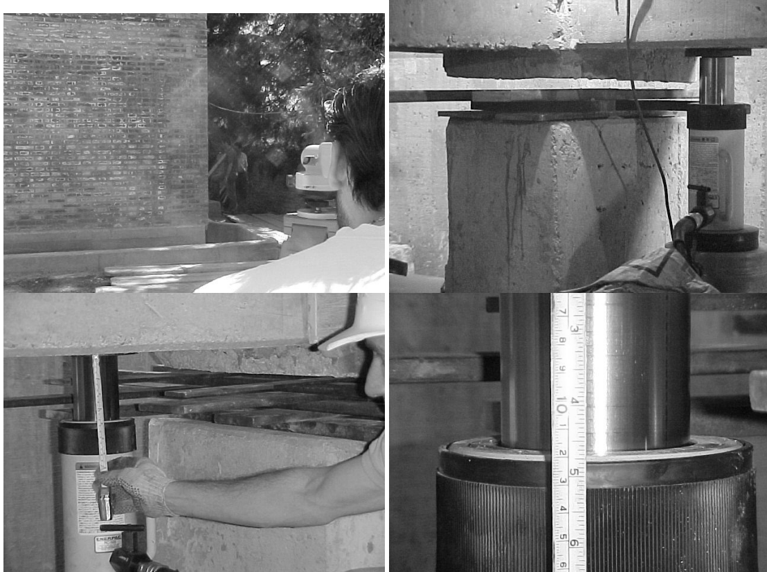
Figura 41 Instancias de control durante el proceso de levantar el edificio.
