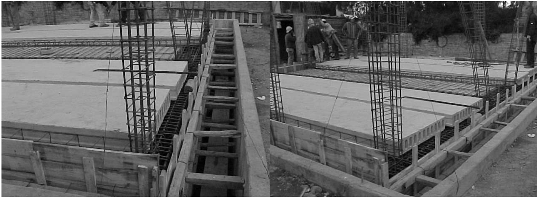
Figura 19 Losas ubicadas por encima de los dispositivos de aislamiento
