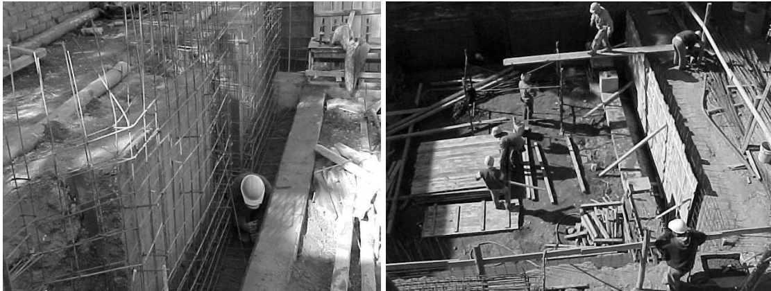
Figura 16 Construcción del tabique perimetral de hormigón armado del subsuelo
