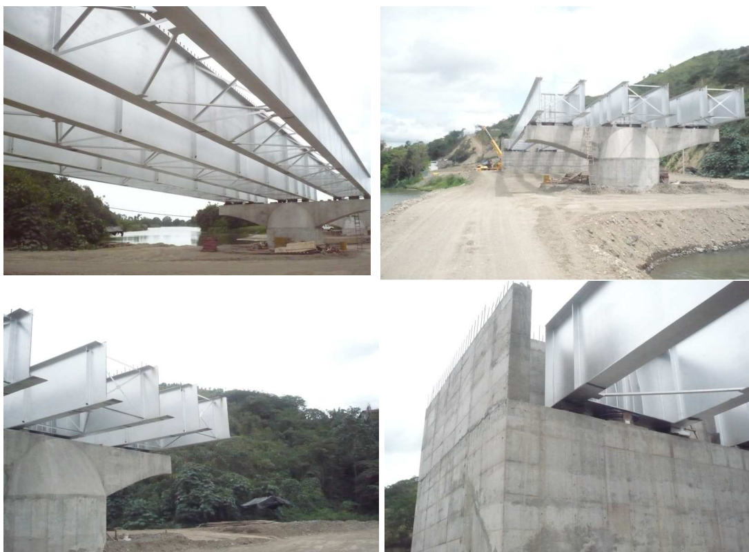
Figura 25 Vigas de acero del Puente Sur.
