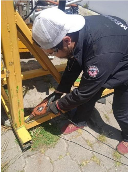
*Nota.* Lijado con gratas para la remoción de oxido en la estructura.
