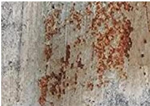
*Nota.* Oxido superficial en partes de la estructura.
