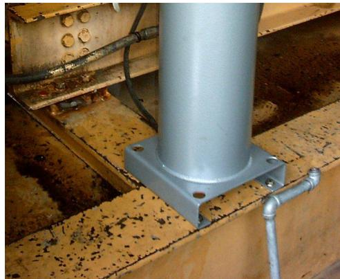
**Figura 4.3** Anclaje de base metálica
