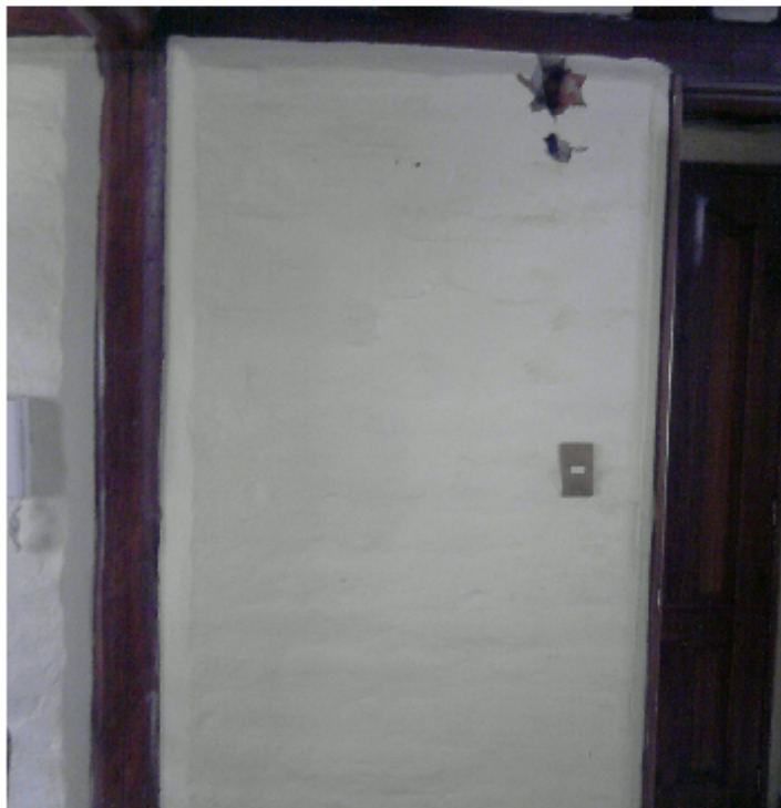
Fig. 59 Agujero para el aprovechamiento de las tuberías instaladas.
