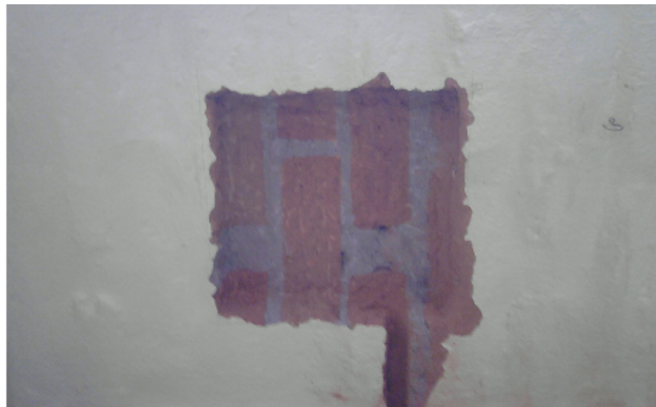
Fig. 58 Agujero para la Caja de registro de la estancia Escaleras .
