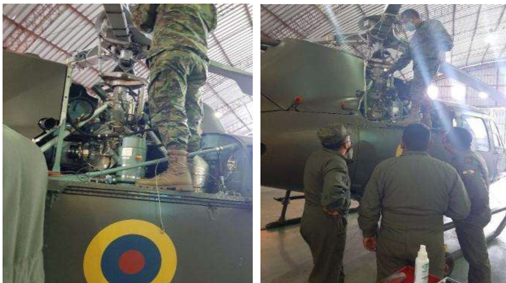
Figura 60 Instalación del equipo en el rotor de principal
