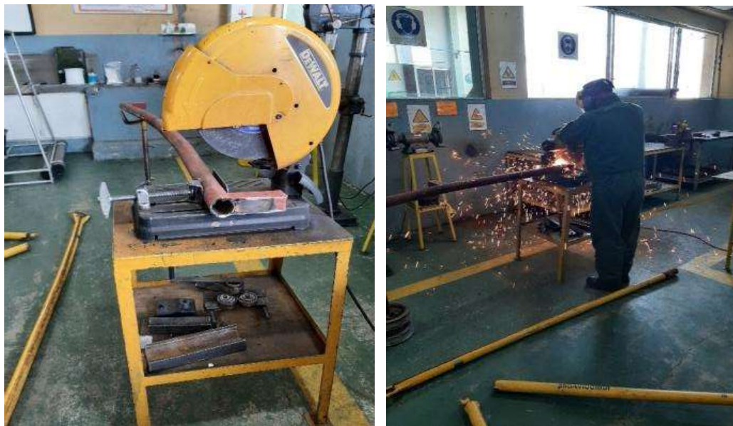
Figura 66 Corte de tubos
