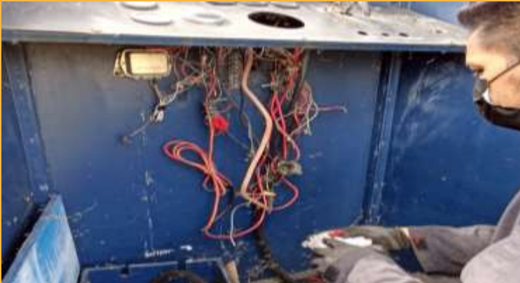
Inspección del área eléctrica del motor Volksplae
