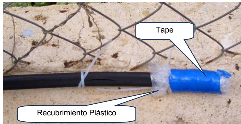
Figura. 5.74. Enrollar en cinta adhesiva
