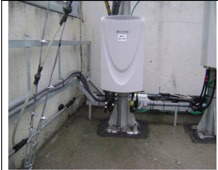
FOTO N°. Descripción: Etiquetado, encintado de feeders (RRU) 5
