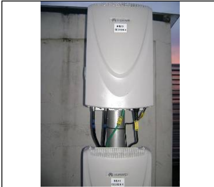
FOTO N°. Descripción: Etiquetado, encintado de feeders (RRU) 5
