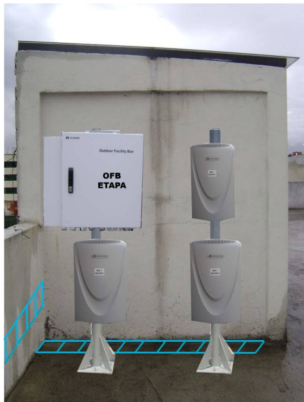
Ubicación de Equipos UMTS , BBU en OFB en Polo / Rack y RRUs
