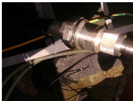
Figura. 5.16. Cable RF y Transición DIN 7/16 a N
