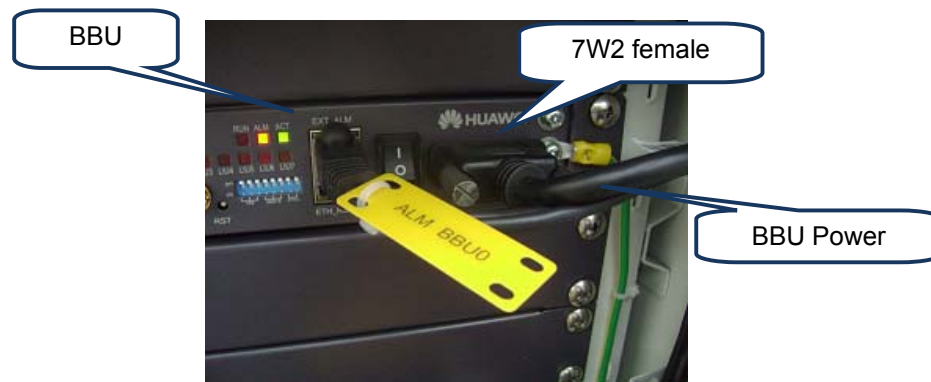
Figura. 5.53. Conexión del Cable de Alimentación al módulo BBU
