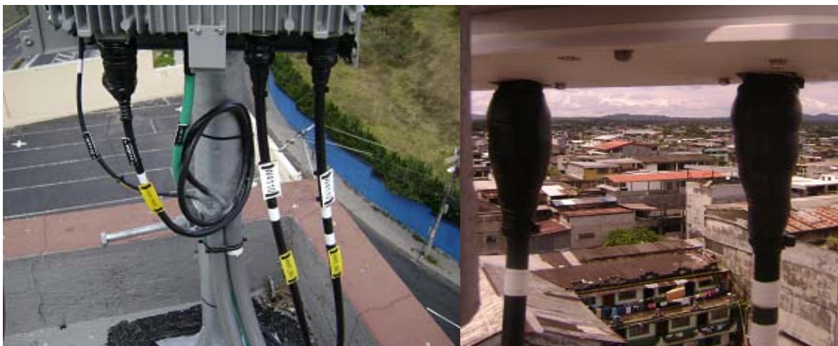
Figura. 5.18. Impermeabilización de Conectores
