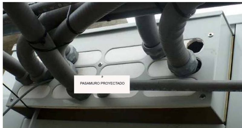
Figura. 4.18. Pasamuro a ser Utilizado para Transmisión (E1)
