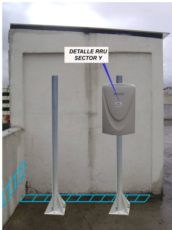
Ubicación de la RRU del Sector Y en Polo (Torre/ Plataforma) o en Rack
