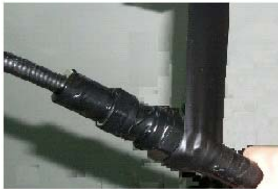
Figura. 5.89. Impermeabilización de Kit de puesta a tierra
