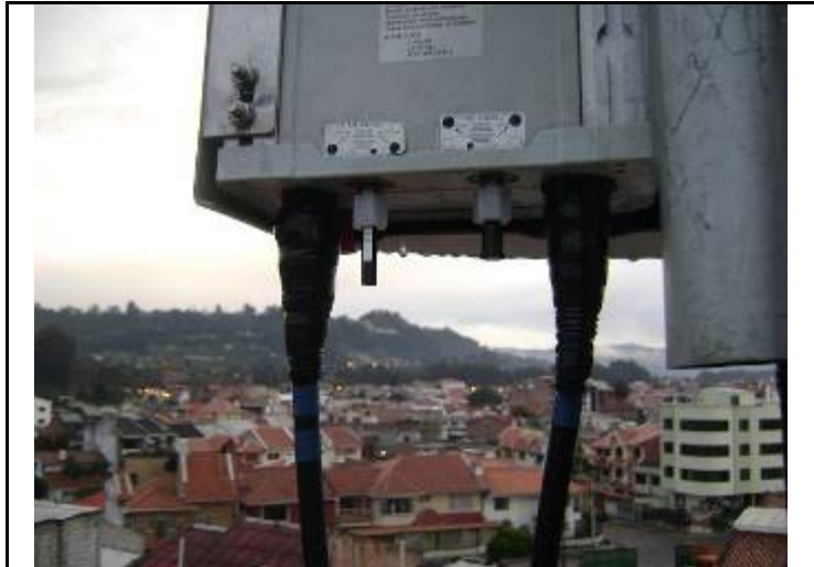
FOTO N°. Descripción: Etiquetado, encintado de feeders (Antena) 6
