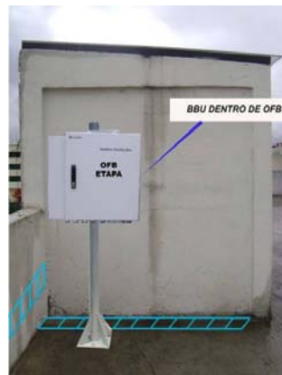
Figura. 4.3. Ubicación de la BBU en OFB en Polo / Rack
