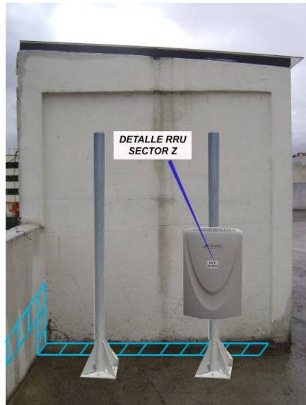
Ubicación de Equipos UMTS , BBU en OFB en Polo / Rack y RRUs
