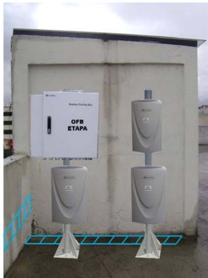
Figura. 4.8. Ubicación de Equipos UMTS, BBU en OFB en Polo / Rack y RRUs
