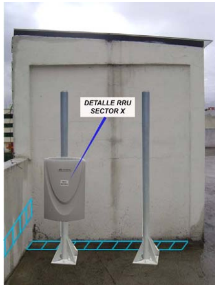
Figura. 4.5. Ubicación de la RRU del Sector X en Polo (Torre/ Plataforma) o en Rack
