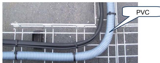
Figura. 5.63. Colocación de cable de alimentación en tubo de PVC
