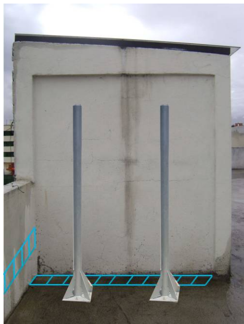
Ubicación de Polos a ser ubicado en base de Concreto
