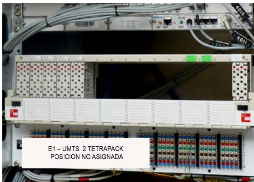
Figura. 4.14. Ubicación del Tetrapack (E1's a ser Utilizados) en panel de Transmisión localizado en Power One / Nuss / Rack de 19"
