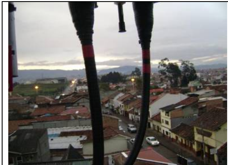
FOTO N°. Descripción: Etiquetado, encintado de feeders (Antenas) 6
