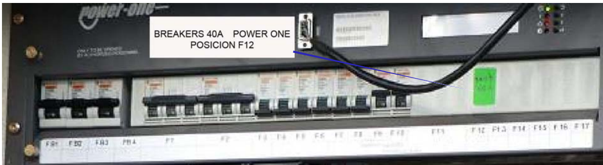
Ubicación del Breaker a Utilizar en el panel de NUSS/ Power One / Power Plant
