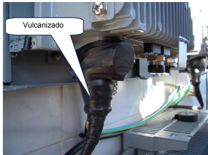
Figura. 5.61. Instalación de tapa impermeable del conector de alimentación de RRU
