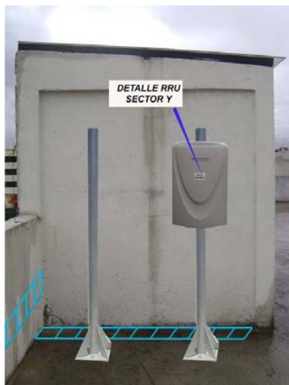
Figura. 4.6. Ubicación de la RRU del Sector Y en Polo (Torre/ Plataforma) o en Rack
