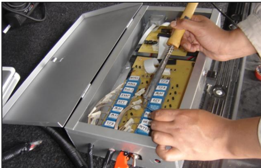
Fig. 4.30 Instalación del cableado en el módulo
